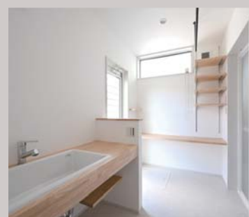
ペットが洗える深型のシンク。横から 落ちないように袖壁も付けました。
