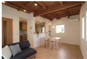
梁や天井は構造材を活かし、自然素材で優しいぬくもりのある内装に。木の持つ調湿性も利用。
