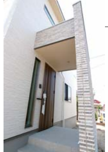
雨の日も安心の 屋根のある玄関ポーチ。
