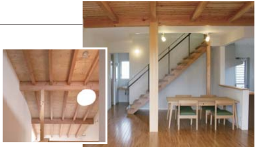
梁や天井は構造材を活かし、自然素材 で優しいぬくもりのある内装に。 木の持つ調湿性も利用。
